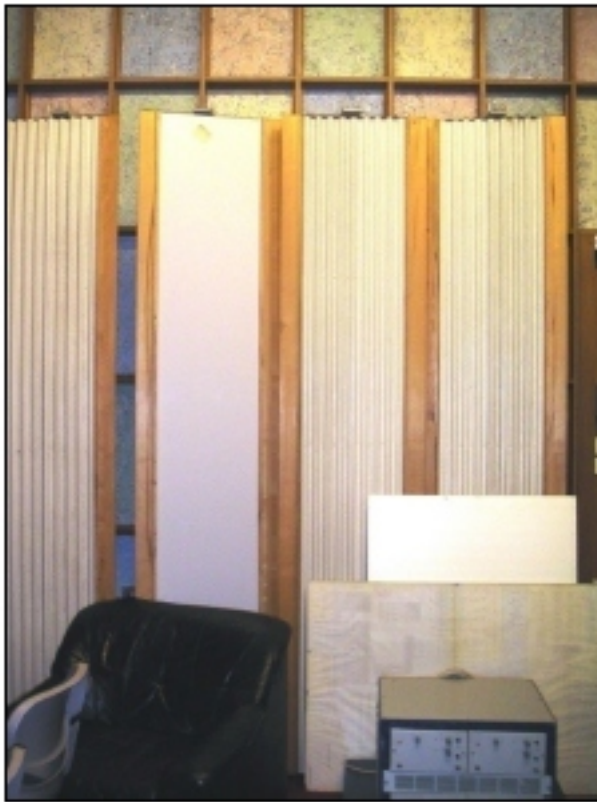
Bild 9.39. Hörspielstudio H 2/1, Drehsäulen, seitlich vom Sprechertisch. (Foto: G. Steinke, 2007)
